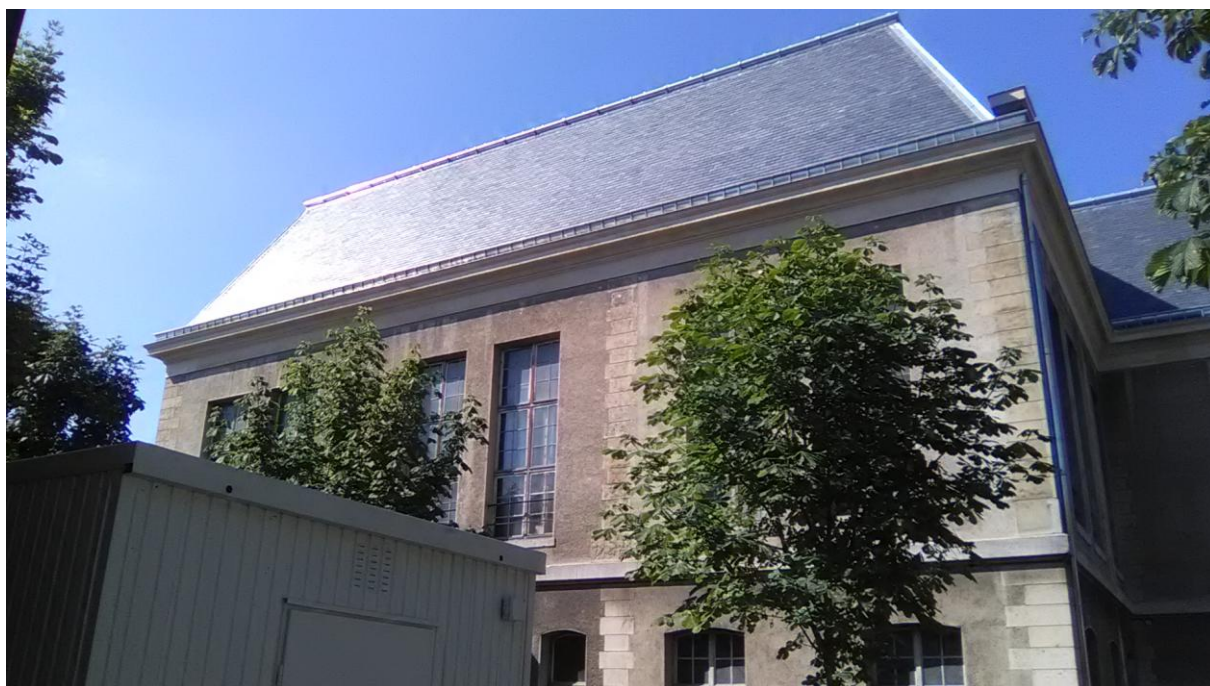
Le toit flambant neuf du musée des moulages de l'hôpital (photo B. Pastisson)
